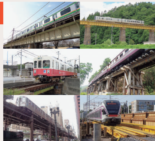
鋼製橋桁の例
