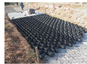
ジオセル補強路盤
