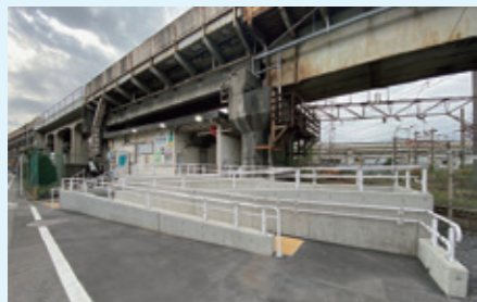
JR 鶴見線 現地調査の様子
