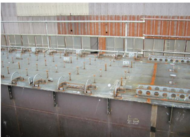
鉄道用合成桁橋梁に使用されるずれ止め（筆者撮影）
