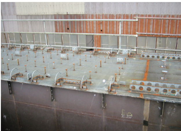
鉄道用合成桁橋梁に使用されるずれ止め（筆者撮影）
