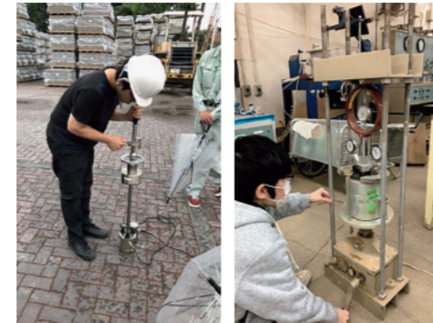
小型FWDを用いた現場試験
