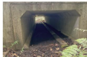
写真3 道路下に設置されたヤンバルクイナのトンネル(筆者撮影)
