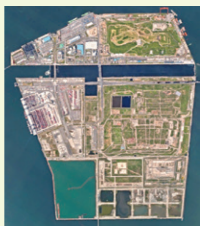
プロジェクトの舞台である「中央防波堤エリア」。現在埋立工事中であり、完成後は1,000haを超える巨大な人工島となる
