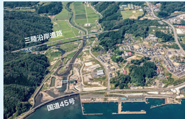
津波の浸水を受けないように整備された三陸沿岸道路
