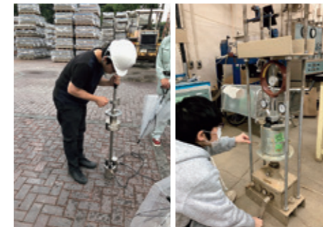
小型FWDを用いた現場試験
