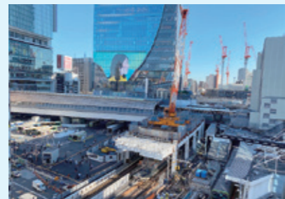
JR 渋谷駅工事の様子
