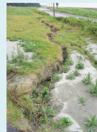
写真3 液状化により砂が吹き出し発生した地割れ
