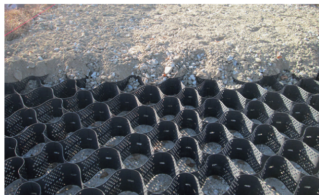
▲写真-1 道路の下に敷設されたジオセル
