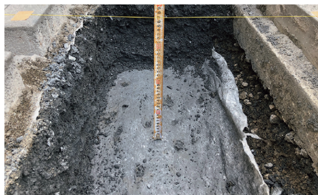
▲写真-4 道路の下に敷設されている舗装用強化ジオテキスタイル(グレーの部分)
