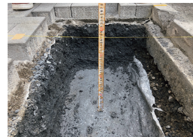
写真2 実際の舗装下に敷設された表面強化不織布
