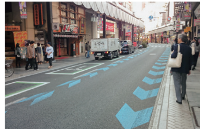
▲ 路上駐車施設と自転車走行空間整備
