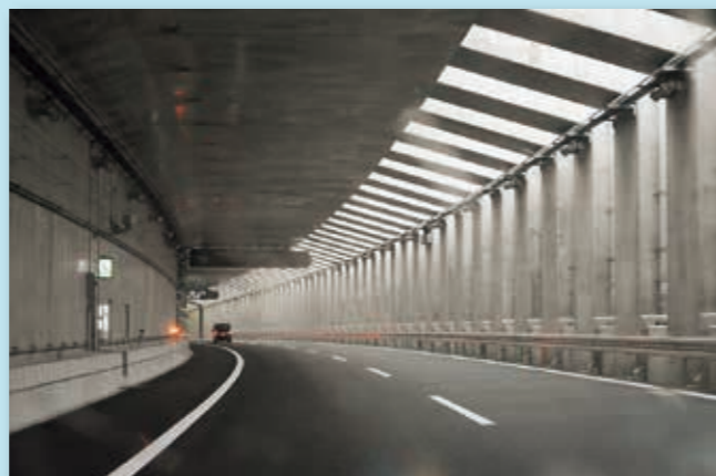
図2 開通した外郭環状道路
