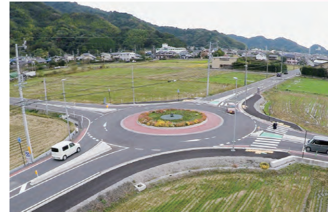
▲ 静岡県焼津市のラウンドアバウト
