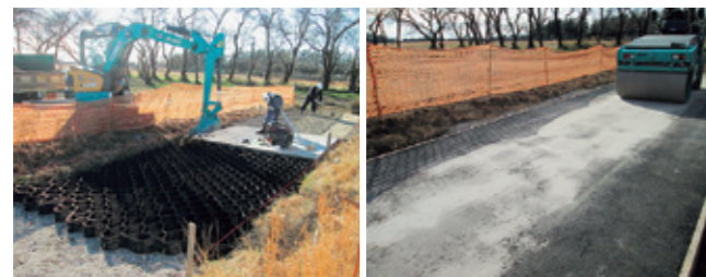
▲ ジオセル現場走行試験状況(左：施工状況、右：走行試験状況)
