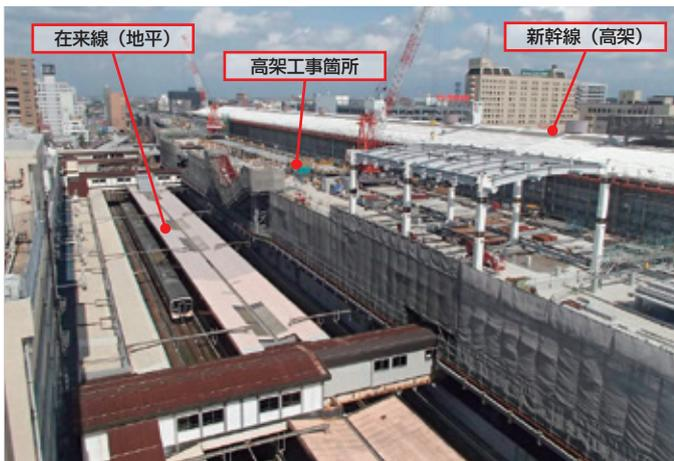
新幹線と在来線に挟まれたスペースで新しい高架駅を新設する新潟駅付近高架化工事
