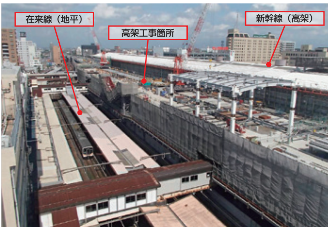
新幹線と在来線に挟まれたスペースで新しい高架駅を新設する新潟駅付近高架化工事
